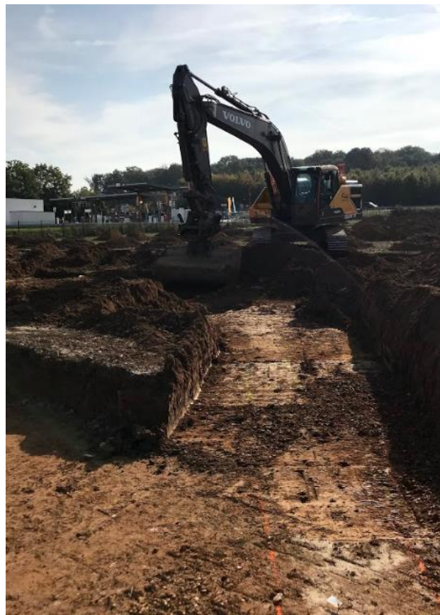
Figure 24 : Photographie prise lors de la visite du chantier d'Allonne.
