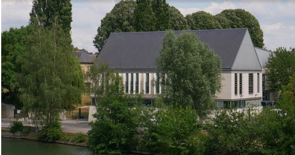
Figure 13 : Vue du bâtiment du CRAVO depuis le Pont Neuf
